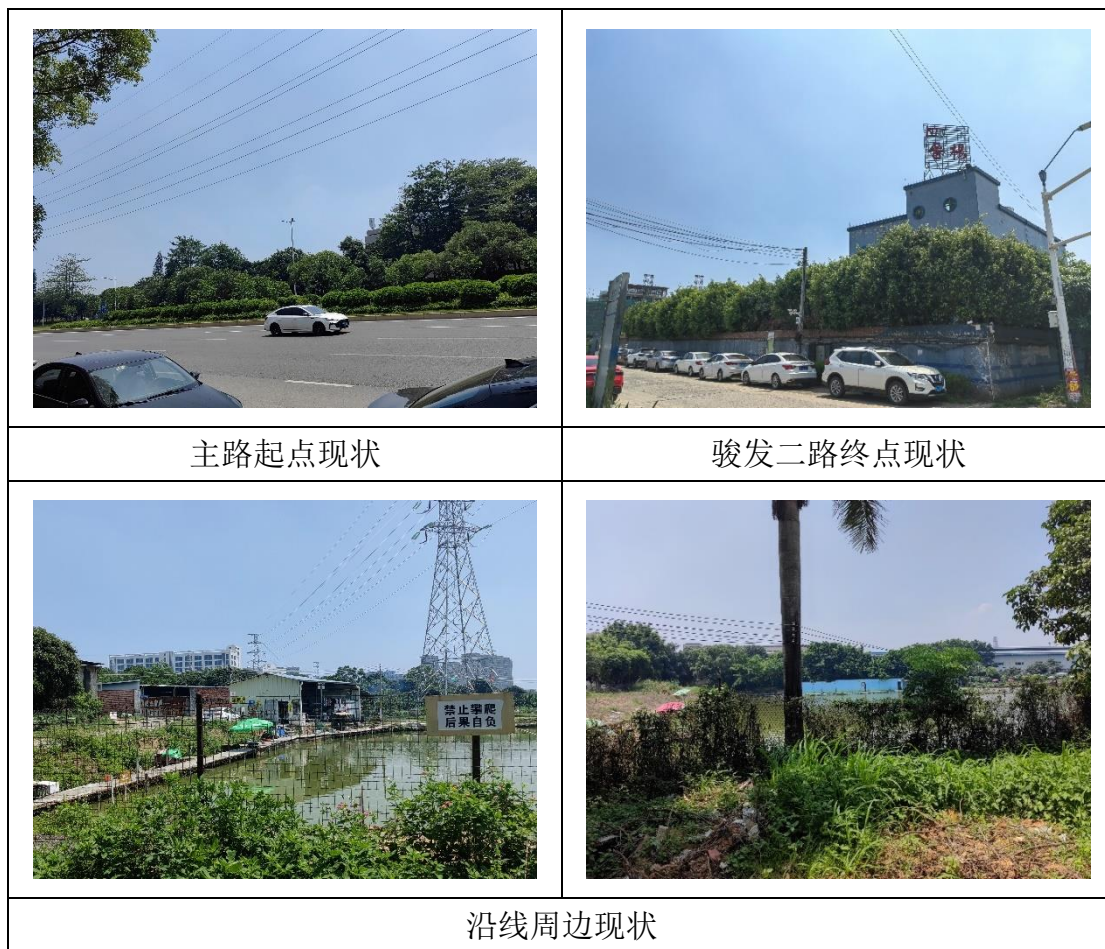
图 2.3-2 工程现状实景图
